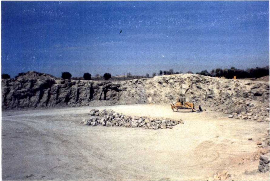
VISTA DEL FRENTE ANTES DE LA VOLADURA
